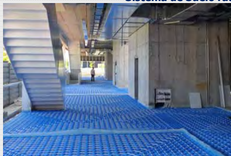
Sistema de Suelo radiante en todo el centro
