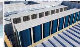
Central producción Aeroterminia
