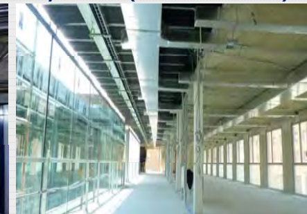
Ejecución de instalaciones ordenada y accesible (Fácil mantenimiento)
